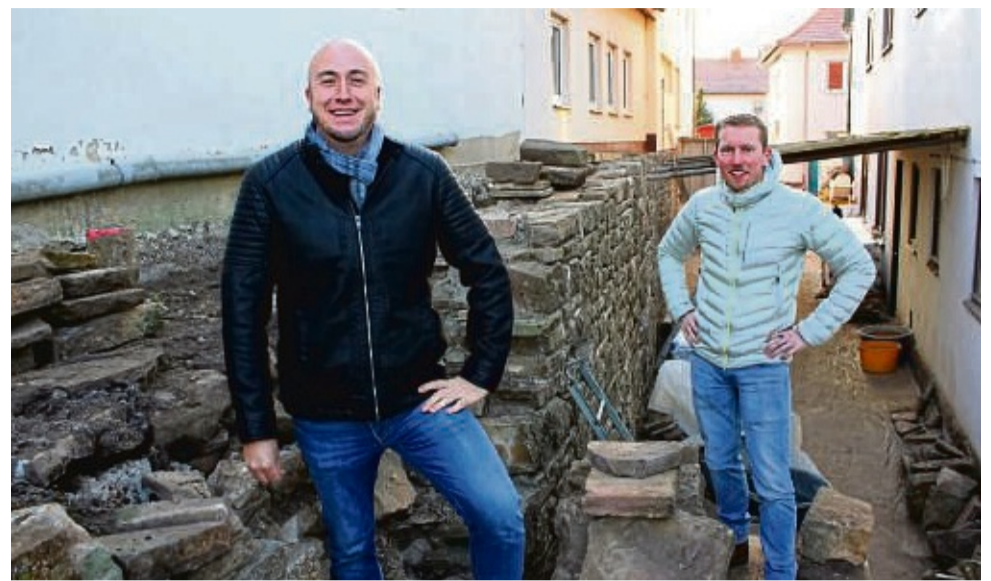
Sanierung kommt voran: Bürgermeister Martin Lange und Bauamtsleiter Patrick Pfeiffer bei einer Besichtigung der Baustelle der Trendelburger Stadtmauer. FOTO: HARALD SCHMIDT
